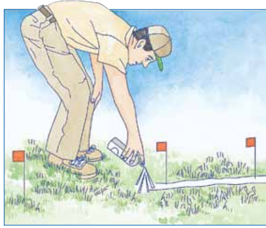
Kazı öncesi, küçük bayraklar ve sprej boya kullanarak sulama sisteminin yatırılacağı alanı belirleyin.
