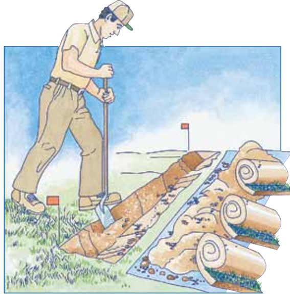
Önce muşamba yayın ve çim rulolarını 25 ile 30 cm derinliğinde kazarak ana hatta yer açın. Lateral hatlar için kazıyı 15 ile 20 cm yapın.
