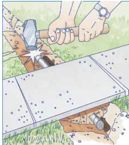
Yürüyüş ve araç yolları altından galvaniz boruyu, iki ucunu kapatıp çakarak bağlayın.
